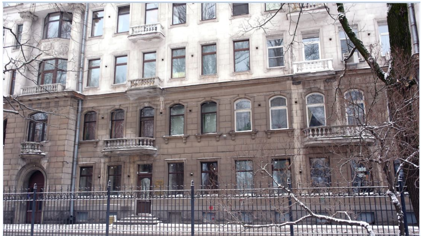
Каменноостровский проспект, дом № 73/75.
